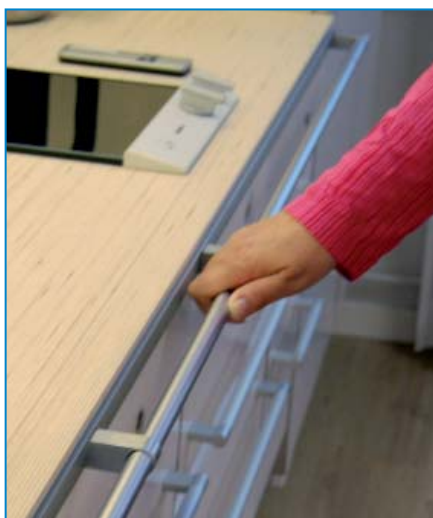
Kuva 32. Työtason kiinnitetystä tartuntakaiteesta saa tarvittaessa ottaa tukea. Kuva: Anneli Reisbacka.
